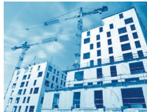
Chantier du bâtiment «Sensations» © KOZ Architectes-ASP Architecture
