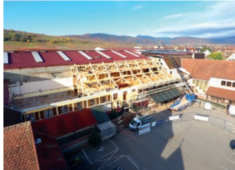
Nouvelle charpente, Kauffmann & Wassmer Architectes © KWA
