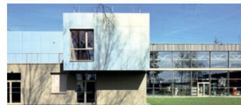
Bâtiment Génie civil – IUT Robert Schuman © Mongiello & Plisson
