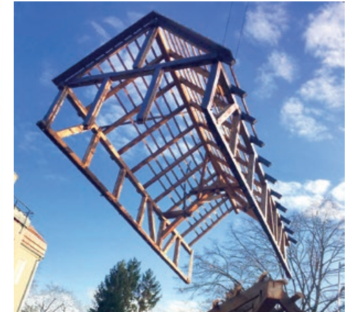
Envol de charpente, rue de la Paix, Wissembourg © Carmen Roegels
