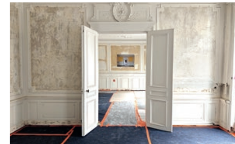
Chantier de l'ancienne Chambre régionale des comptes d'Alsace © Benjamin Kiffel
