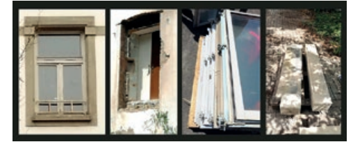
Déconstruction sélective © nunc architectes
