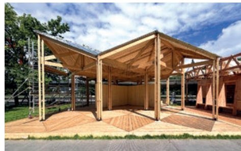
Le pavillon ArchiFolies au parc de la Villette © Alexandre Grutter
