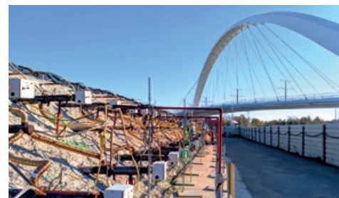
Plateforme de désorption thermique au nord du quartier Citadelle © SPL Deux-Rives
