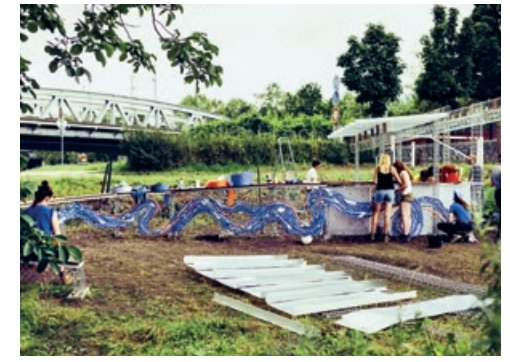
Chantier du bar extérieur de l'Orée 85 en matériaux de réemploi © Abdesslam Mirdass
